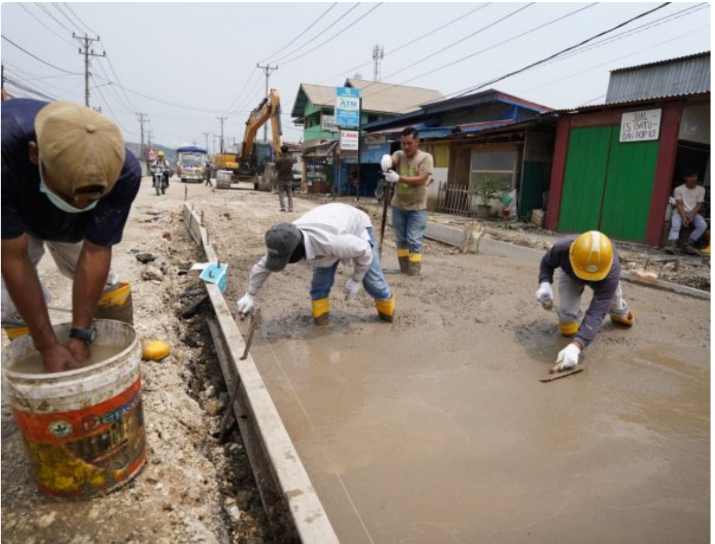
Tampak proses perbaikan jalan nasional oleh PT IMIP
