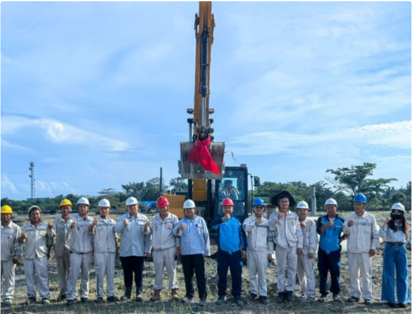
Pembangunan Gedung training center di lingkaran industri PT IMIP
